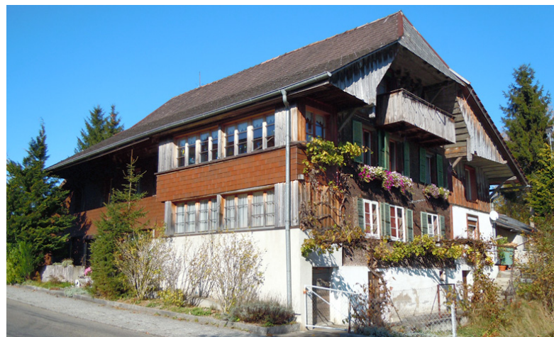
Unten: Letztes Anzeichen von Bewohnbarkeit stellt im Jahr 2011 der Blumenschmuck an der Hausfassade dar. Heute verlottert, zeugen Bauprofile von bevorstehender Bautätigkeit.
