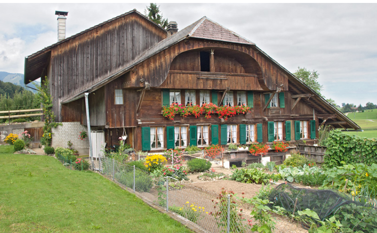
Oben: Das Haus auf der Schindlernweide, der ehemals unausgeteilten Hofallmend, blieb bis ins Jahr 2020 praktisch in ursprünglichem Zustand und wurde ab dem Jahr 1954 bis 2014 von der Familie Bacher-Zweiacker bewohnt (zuletzt Verena Bacher † 2014).
