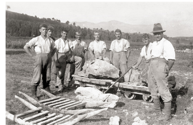
Drainagearbeiten auf dem Reutigmoos im Bereich der Büeltenen. Vermutlich entstand das Foto während den Entsumpfungsarbeiten Ende der 1920er-Jahre. Wer kennt die Namen der Arbeiter?
