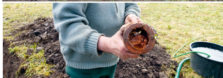
Bilder oben: Reparatur und Spülung der Drainageanlage – Die Tonröhren sind zirka 1,5 Meter unter Terrain aneinander stossend verlegt. Der Spülschlauch arbeitet sich dank speziell konstruiertem Spülkopf mit nach hinten gerichteten Öffnungen durch die Leitungen. Bild unten zeigt die Ocker-Ablagerungen in den Leitungen.
