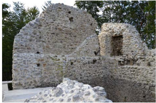
Die Mauer des dritten Stockwerks, welche wegen fehlender Brandspuren einer späteren Phase zugeordnet werden muss, entpuppte sich als u-förmiger Aufbau mit vermutetem, südseitigem Abschluss in Holzbauweise.
