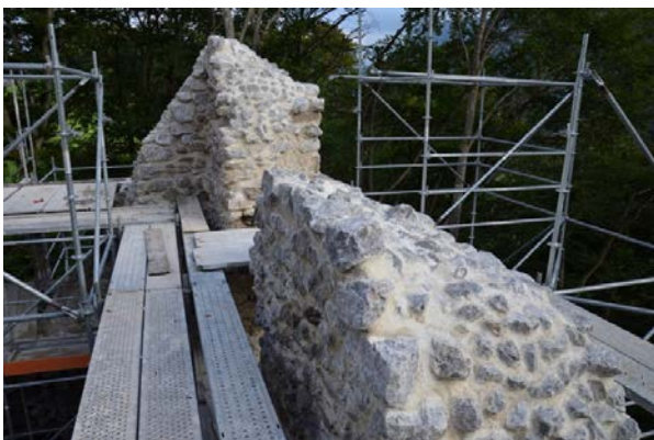
Wiederum bohrte und verklebte ein Bergführer Seil-Fixpunkte auf den Mauerkronen um ab und zu Laub oder neuen Bewuchs gesichert entfernen zu können.
