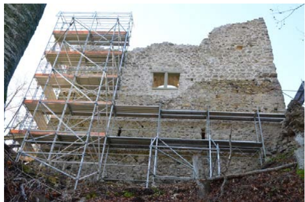
An einigen wenigen Führungen liessen sich rund dreissig Besucher den sanierten Wohnturm in luftiger Höhe und aus besonderen Blickwinkeln zeigen.
