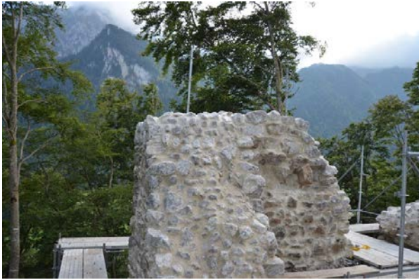
Die Balkennegative des zweiten Bodens über dem «Piano nobile», der Etage der Herrschaften, konnten fachgerecht erhalten werden und zeugen anhand der engen Balkenabstände von einer intensiven Nutzung.
