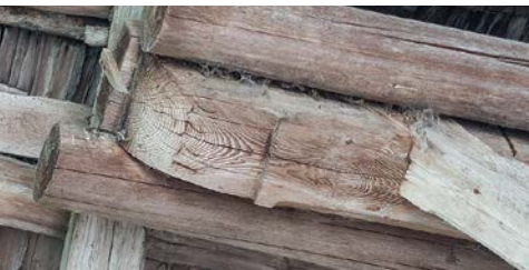
Das eingrafierte Baujahr 1777 am Firstbalken der nebenstehenden Scheune Nr. 83a.
