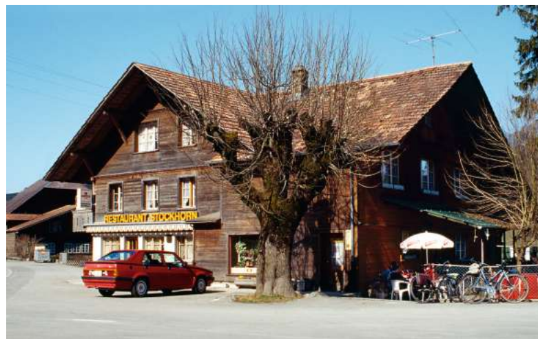
Das alte Restaurant Stockhorn 1996, ein Jahr vor dem Abbruch.
