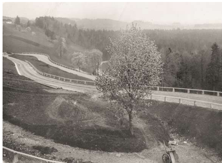
Im Frühjahr 1923 ist der Bau des «neuen» Steghaltenstutzes weitgehend vollendet. Im Vordergrund gut erkennbar die Höhendifferenz des alten und neuen Tracés.
