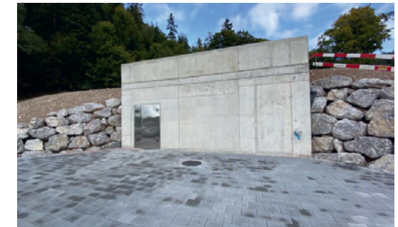
Aussenansicht des neuen Reservoirs
