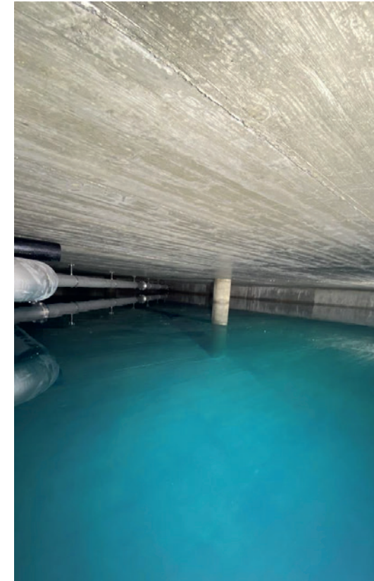
Blick in eine neue Reservoirkammer
