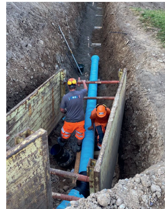
Rohleitungsbau DN 250 aus Duktileisrohr mit Zementmörtel-Umhüllung (Wild AG)
