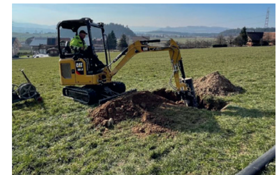
André Zimmermann, Leiter Wassernetz, beim Erstellen des Zugschachts für das LWL – Steuerkabel
