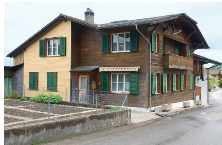
Vor dem Schulhausneubau auf dem Hübeli wurde bis zum Jahr 1882 der westliche Hausteil des Stegenhauses als Schul- und Gemeindehaus genutzt.
