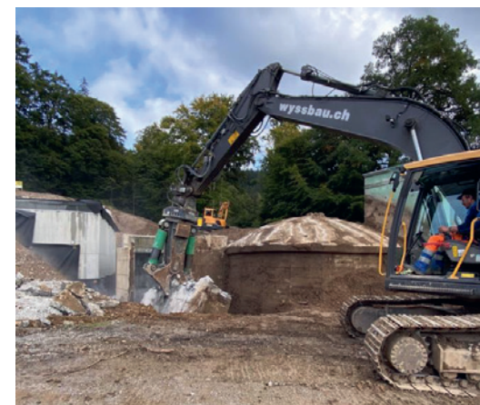
Rückbau des alten Reservoirs, links steht bereits das neue Reservoir
